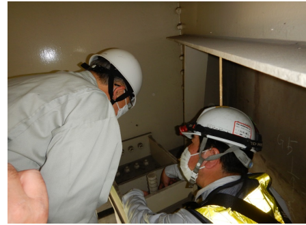
写真-8 合同現地調査状況
