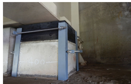
写真-11 緩衝ゴム設置
