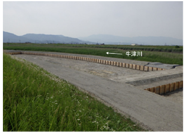
図-10 牛津川における令和4年4月完成の湛水池の様子
