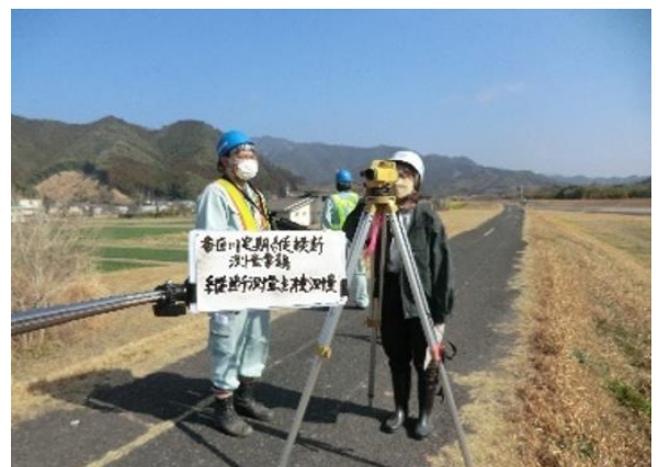
写真-7 点検測量の様子
