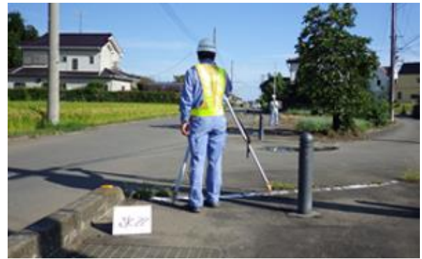
写真-3 調整用基準点の設置の様子
