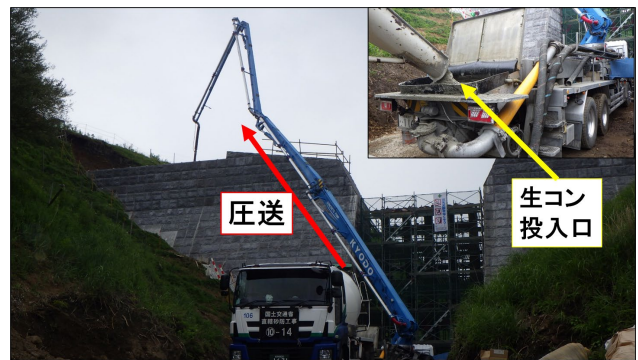
図6 ポンプ打設の様子
