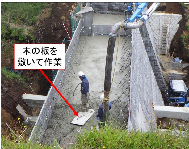
図-8 ポンプ打設の足場の様子
