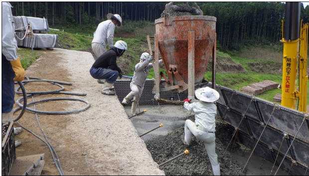
図-7 ホッパーの開閉作業の様子
