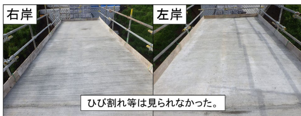
図-10 スランプ8(ポンプ打設)の出来栄え
