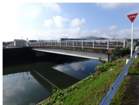
図-5 土器橋の全景
