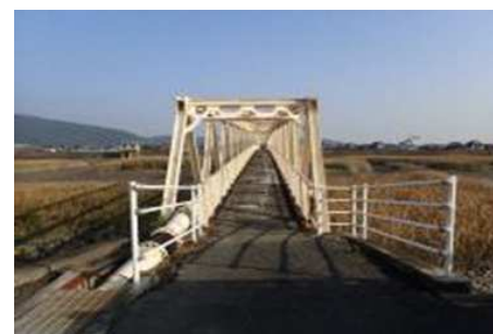
図-2 向井水道水管橋の全景2
