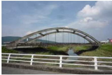
図-3 西牟田虹の大橋の全景
