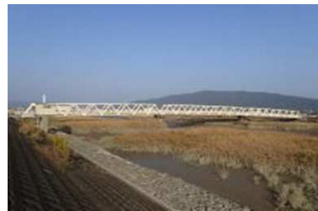
図-1 向井水道水管橋の全景1
