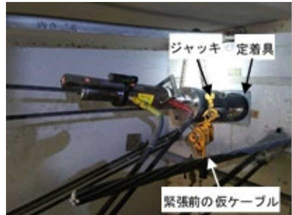
写真-6 外ケーブルの仮復旧状況
