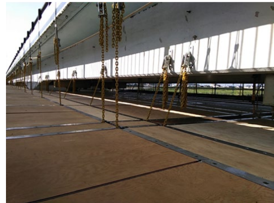
写真-5 システム吊り足場
