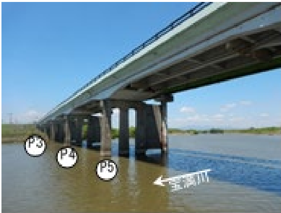
写真-1 千歳橋全景
