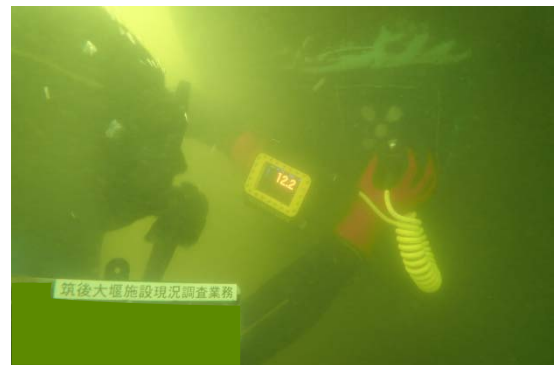
写真-3 潜水士による水位塔肉厚調査
