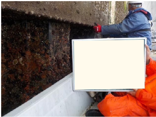
写真-7 小型船舶による緊急点検
