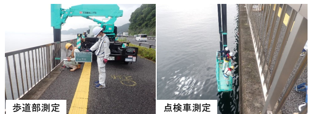
写真-9 電位測定状況
