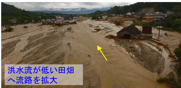
図-1 赤谷川3k付近の河道埋閉塞及び被災状況
