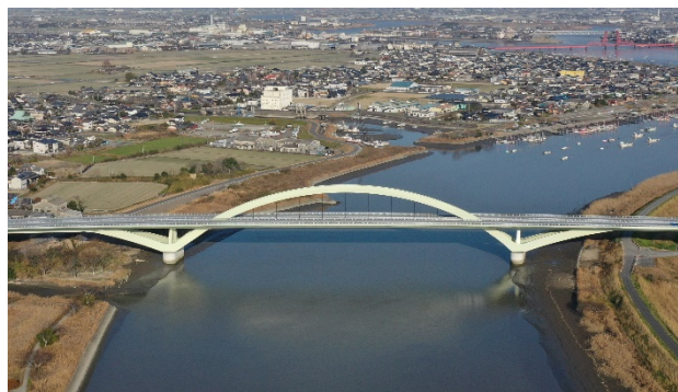
写真-2 （仮称）早津江川橋
