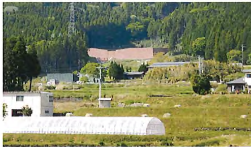
図-6 視認性が高く保全対象が近接した事例
