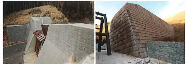
図-9 残存型枠、外部保護材の事例
