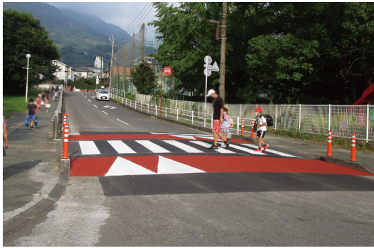
図-7 現地状況（設置後）2021.9.1
