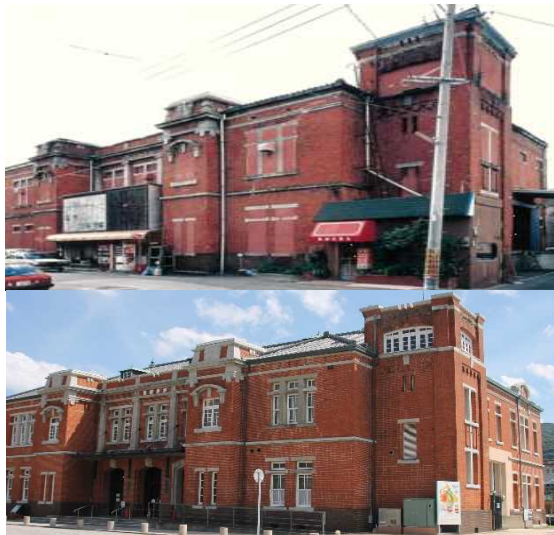
図6 旧門司税関 (上:修復前 5) , 下:修復後)
