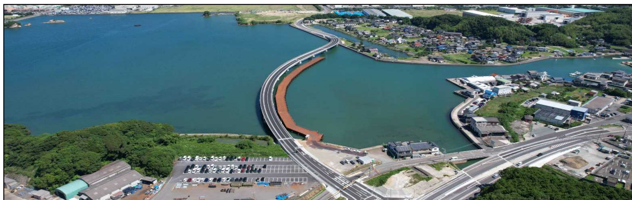
図-11 臨港道路全景
