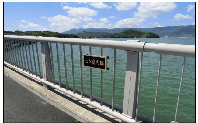
図-8 起点部及び終点部の橋名板
