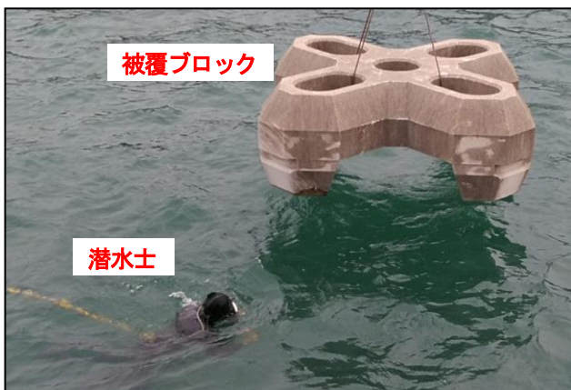
写真-3 被覆ブロック据付状況②
