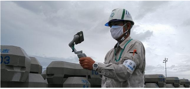
写真-10 遠隔臨場の現場側の状況
