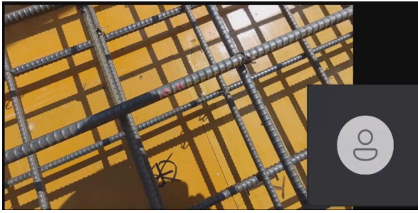
写真2-1 配筋検査
