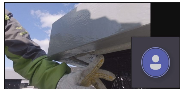
写真4-2 塗膜防水の検査の様子
