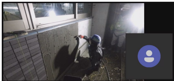
写真5-2 外壁タイル張り付けの様子
