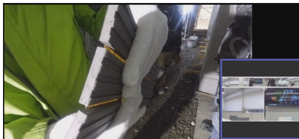
写真5-3 外壁タイル裏足の確認
