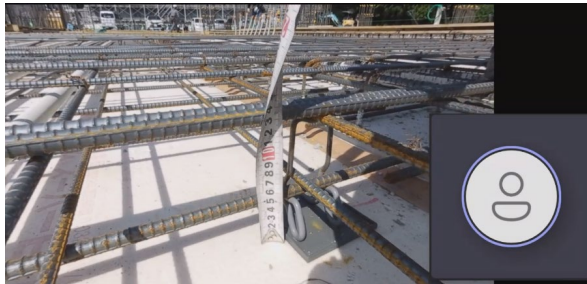
写真2-2 配筋検査
