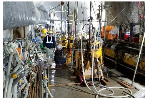
写真-4 施工状況
