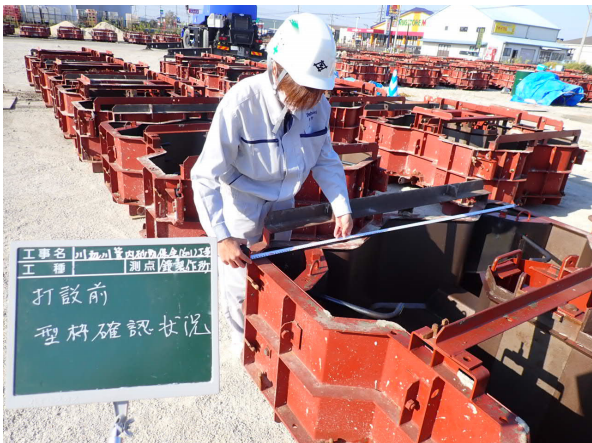
図-9 打設前型枠確認を行う若手女性技術者
