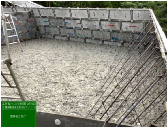
図-8 化粧型枠の設置状況
