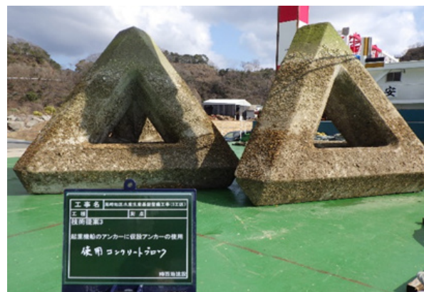
写真-4. 仮設アンカブロック
