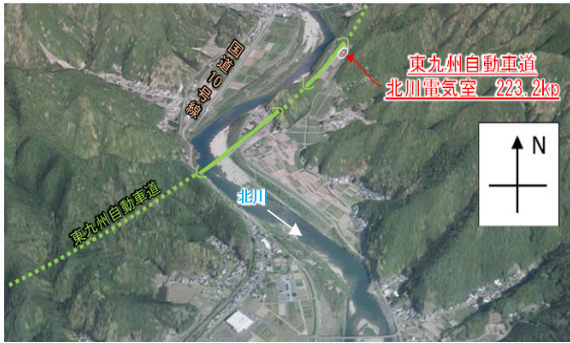
写真-2 北川電気室の周辺（南側が開けている） ※国土地理院地図データより、3D化して作成
