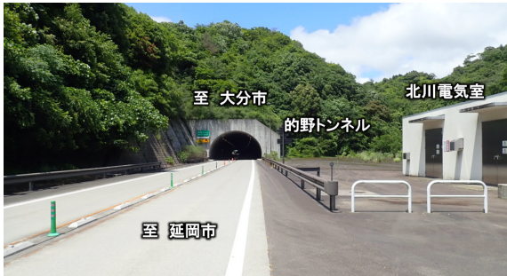
写真-3 東九州自動車道と北川電気室の状況
