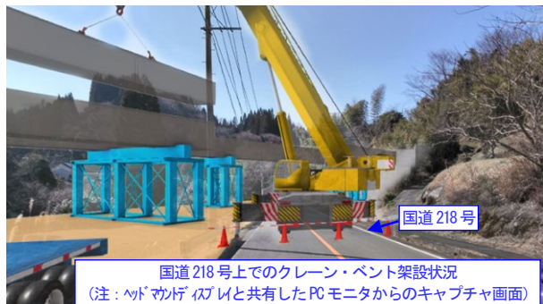
図-10 MR活用①：国道上の架設
