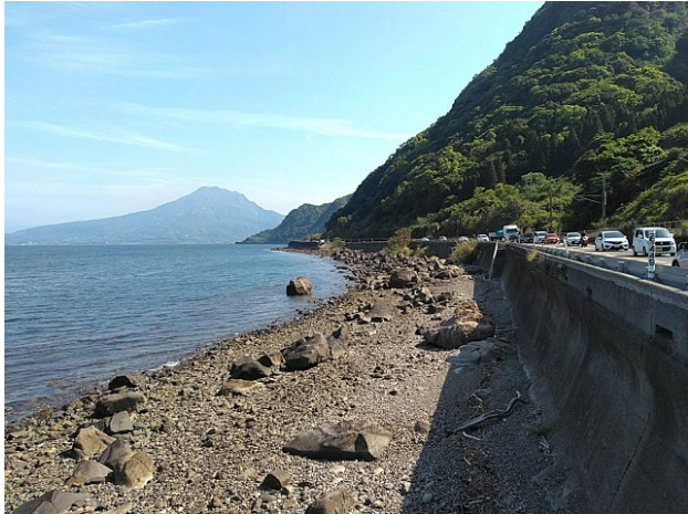
写真-1 白浜拡幅事業箇所の現況写真
