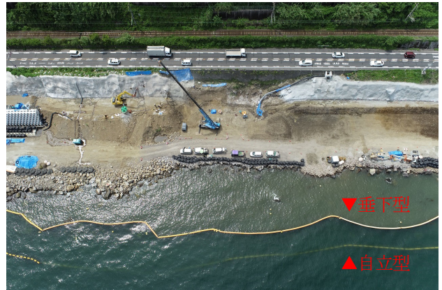
写真-2 汚濁防止フェンス設置状況
