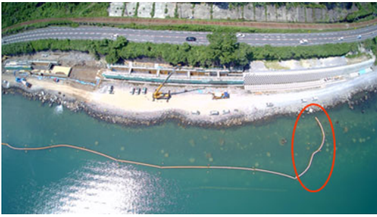
写真-5 汚濁防止フェンス端部の状況
