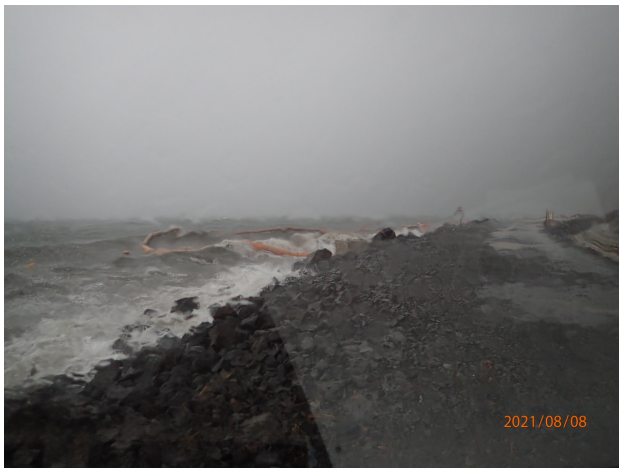
写真-3 台風時の汚濁防止フェンス状況
