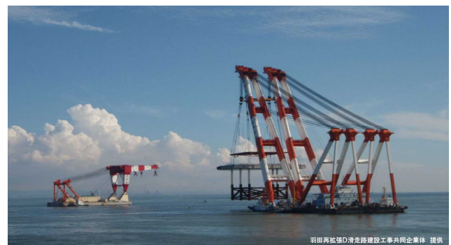
写真-6 羽田空港D滑走路建設工事に使用された作業船
