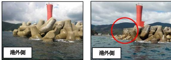
図-3 堤頭部の消波工飛散状況 (左: 2009年, 右: 2020年)
