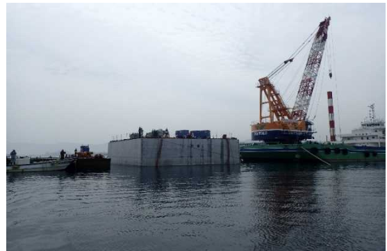
図-15 『ケーソン自動据付システム』据付状況
