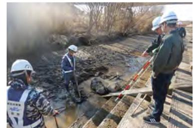
写真-5 置き石設置状況
