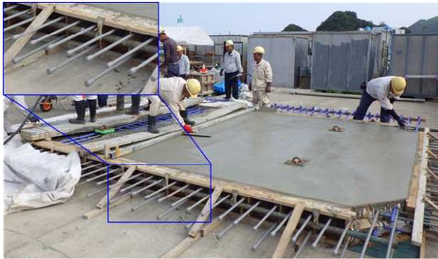
写真-5 SLJスラブ工法によるプレキャスト床版の製作
