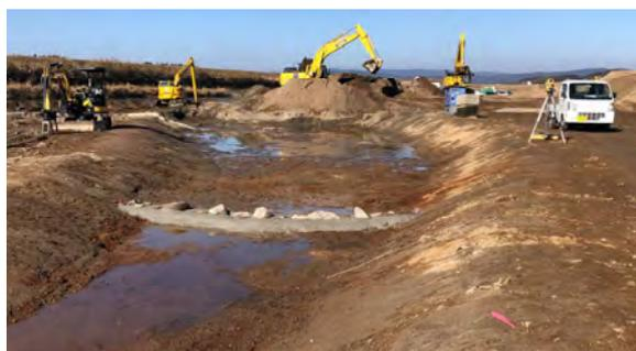
(写真-7) 横断方向の石設置
