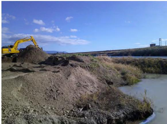
(写真-5) 表土埋戻し状況
