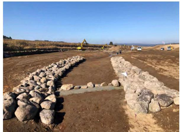
(写真-6) 縦断方向の石設置
