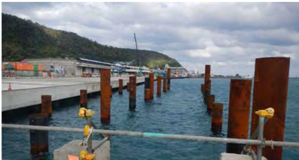
写真4 鋼管杭打設の高止まり状況
