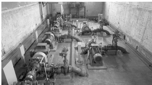
図-6 太郎原取水場設置の取水ポンプ
