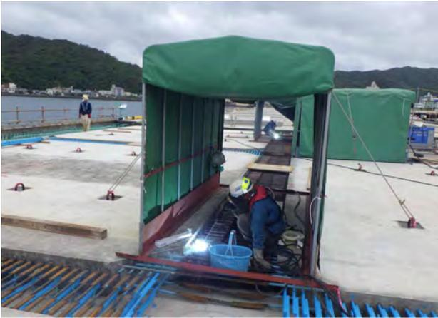
写真3 雨天対策を施した溶接作業状況
