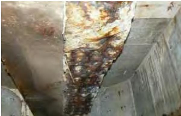
写真-2 栈橋式岸壁における床版下面の老朽化
