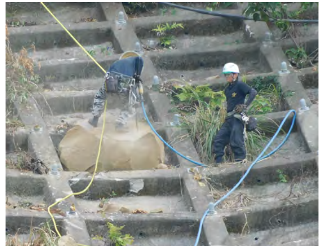
写真10 小割施工状況
