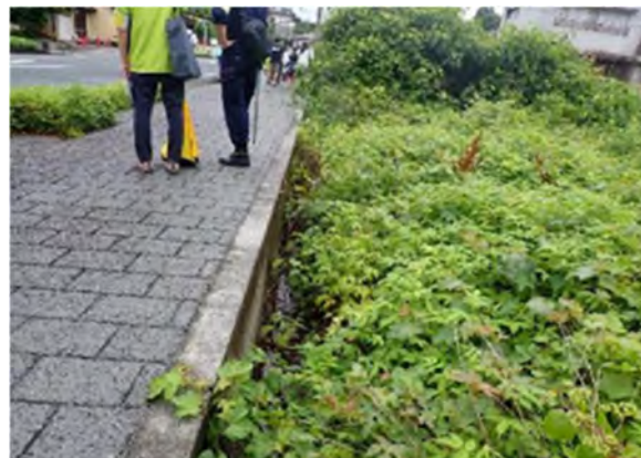
図-9 まち歩き中の危険箇所①
