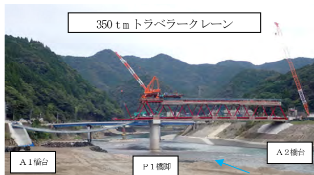
写真-3 350 t mトラベラークレーンによる架設状況
