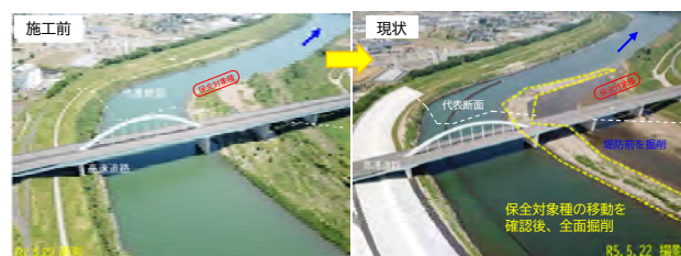
図-11 重要種を保全するための段階的な施工
