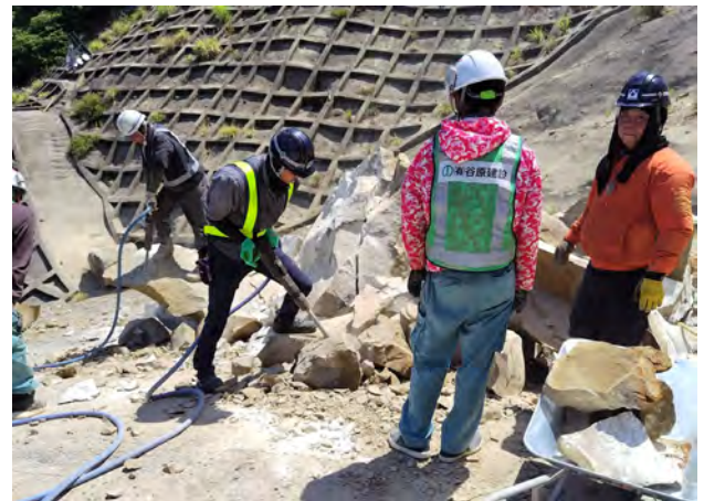
写真11 小割施工状況
