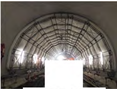
【参考】養生台車による密閉養生
