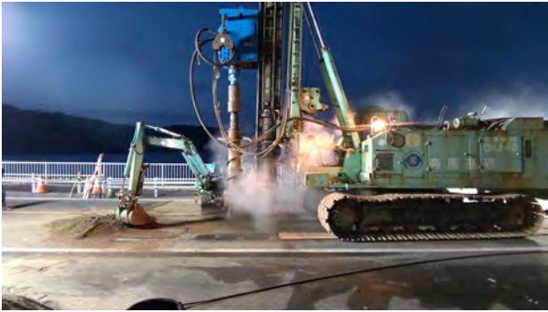
写真5 ダウンザホールハンマーによる削孔（親杭）
