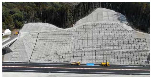
写真-2 対策工の完成状況
