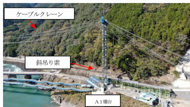
写真-13 斜吊り状況
