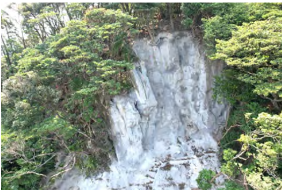
写真8 モルタル吹付工施工状況（落石の剥落部）
