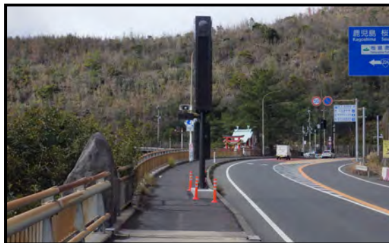
写真3 遮断装置作動中の情報板（上）と手前に設置されている補助情報板（下）
