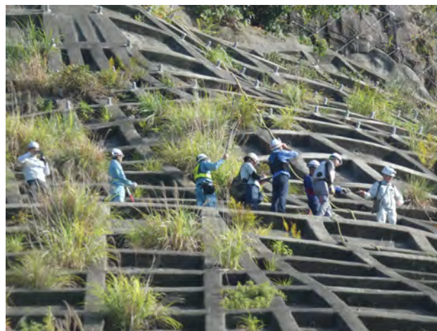
写真4 テックドクターによる現地調査状況
