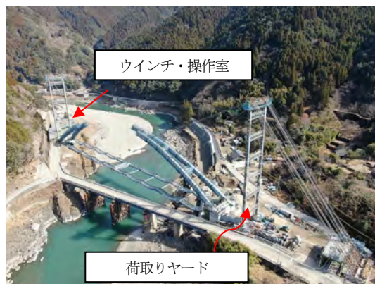
写真-10 A2 側右岸ヤード
