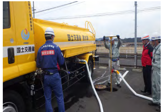
写真一7 簡易水槽への補水
