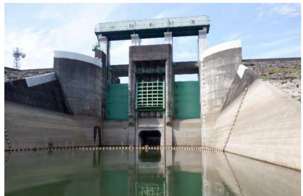
写真-1 寺内ダム洪水吐き部
