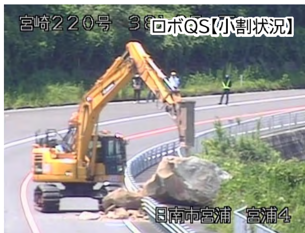
写真3 ロボQSによる小割作業状況
