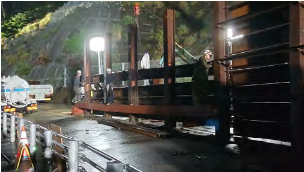
写真6 仮設防護柵矢板取付作業
