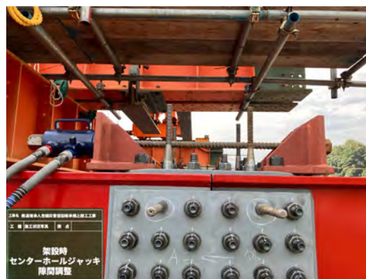
写真-4 センターホールジャッキ使用状況
