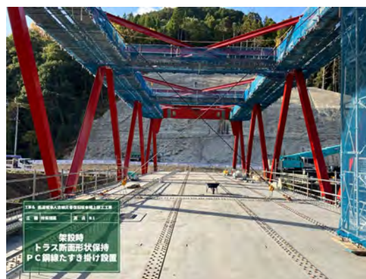
写真-5 トラス断面ねじれ防止状況
