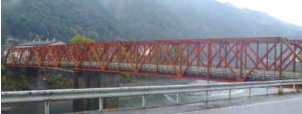
写真-1 旧坂本橋
