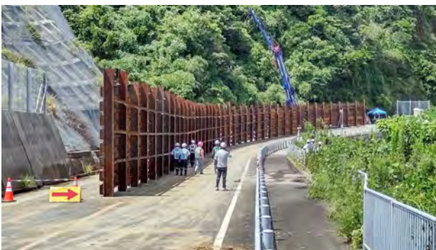
写真7 仮設防護柵設置完了
