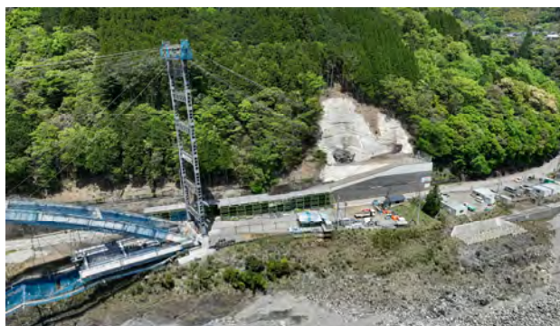
写真-8 鉄塔とグラウンドアンカー設置状況
