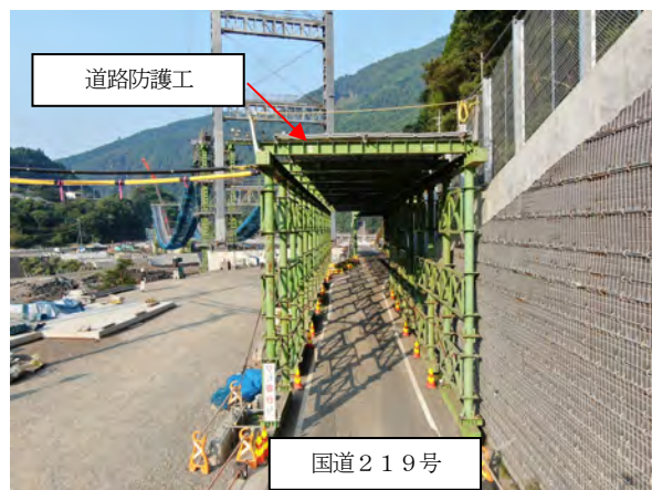
写真-12 道路防護工設置状況
