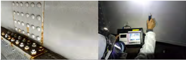
左:素地調整前、右:素地調整後
