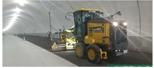
写真-8 ICT施工状況モーターグレーダー
