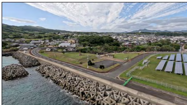
写真-9 既設護岸状況
