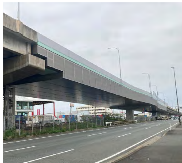
図－19 恒久足場設置完了写真
