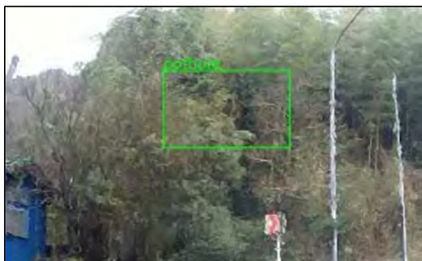
図-10 法面の木の陰を「ポットホール」と検知した例
