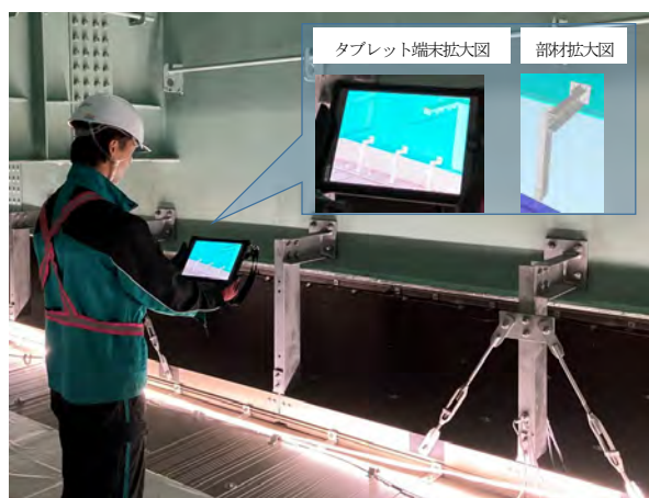
図－18 施工管理状況
