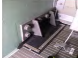
(c) 施工完了写真（干渉部）
