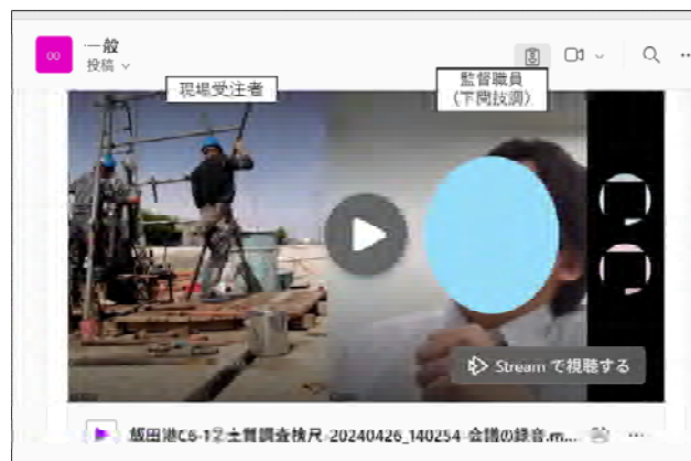
図-8 土質調査における検尺の遠隔臨場の様子
