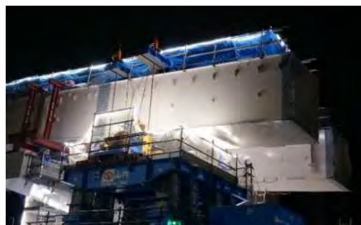
図-13 多軸式特殊台車と桁の固定状況
