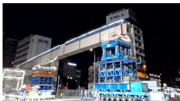
図-4 多軸式特殊台車による一括架設
