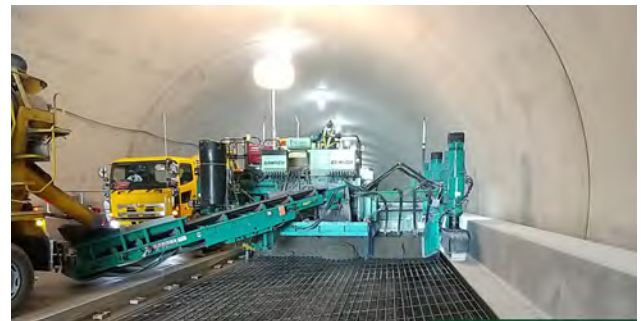
写真-10 ICT施工状況スリップフォーム
