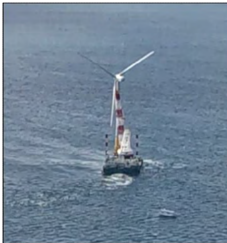
写真-8 洋上風力設備作業状況
