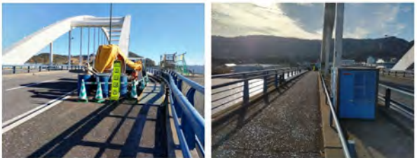
写真-4 機械設置状況
