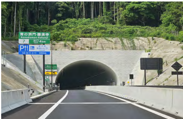
写真-1 八面山トンネル（起点側より望む）
