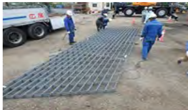
写真-2 ユニット化鉄筋荷下ろし状況
