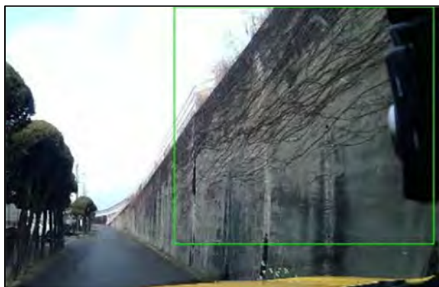
図-11 壁面の蔭を「舗装劣化」と検知した例
