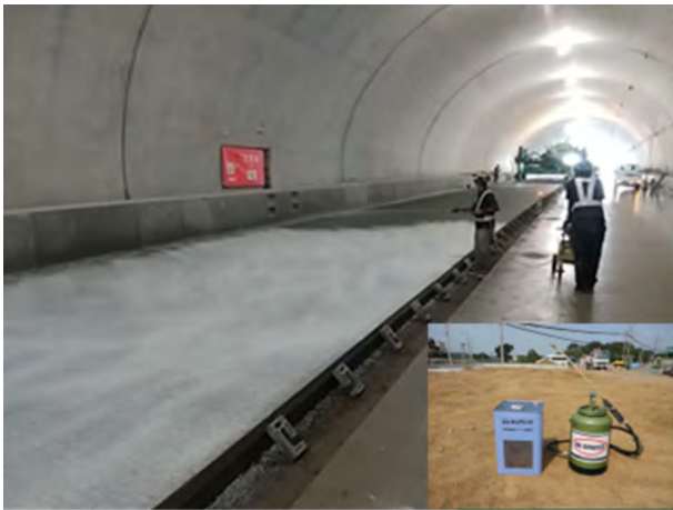
写真-7 被膜型一貫式の養生材での養生
