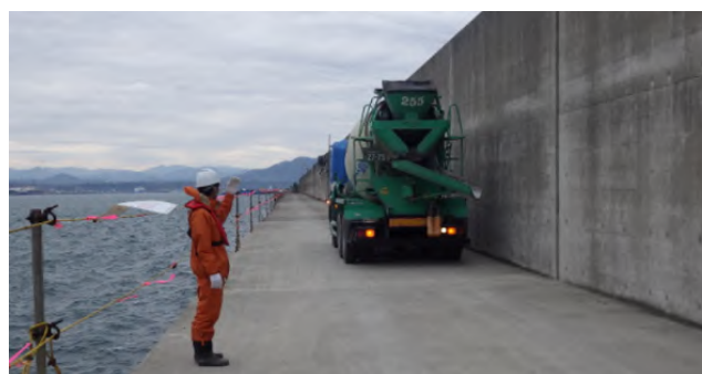
図-6 防波堤でのアジテータ車バック走行
