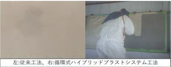
写真-3 粉塵飛散状況(作業状況)の比較
