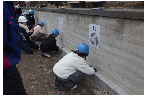
写真-13 ピンコロ石設置の様子
