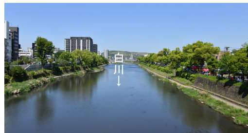
写真-20 現在の緑の区間の様子（2025.4撮影）
