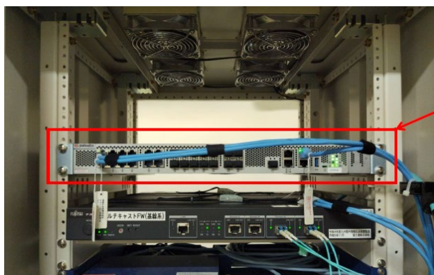
写真-2 導入した次世代ファイアウォール
