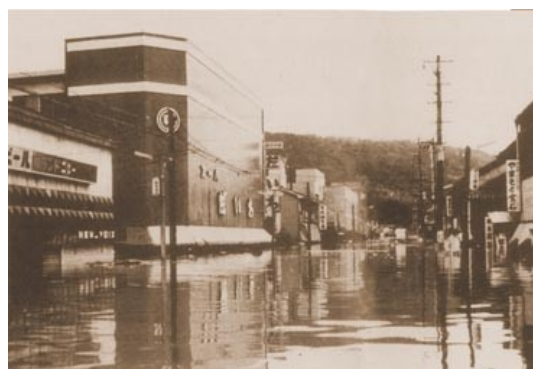
写真-1 市街地浸水状況（薩摩川内市）
