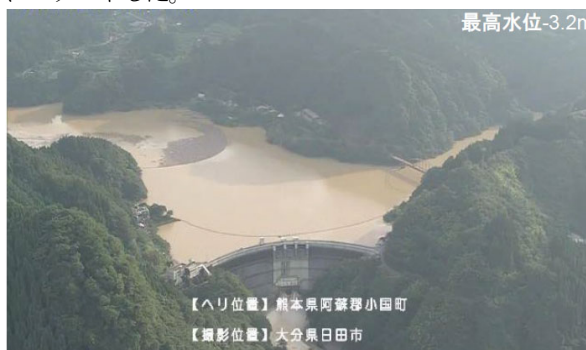
写真-1 令和2年7月豪雨における下笠ダム緊急放流後の状況
