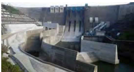
図-2 再開発後の鶴田ダム
