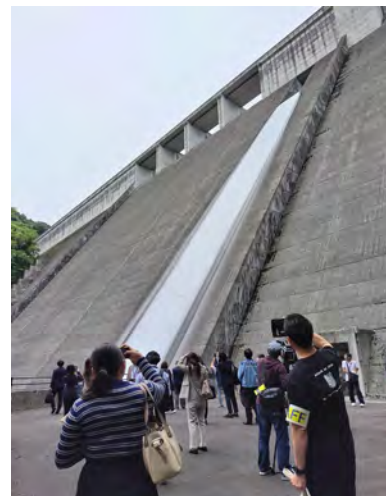
越流している状況を目の前で確認
