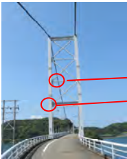
写真-5 主塔全景
