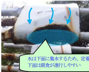
写真-10 耐風索定着金具下面の腐食
