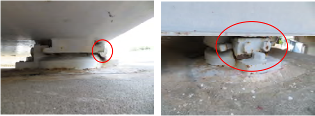
写真-11 サイドブロック破断
