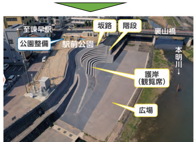
図－３ 駅前公園の堤防整備
