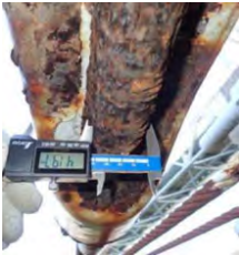
写真-10 耐風索定着金具下面の腐食
