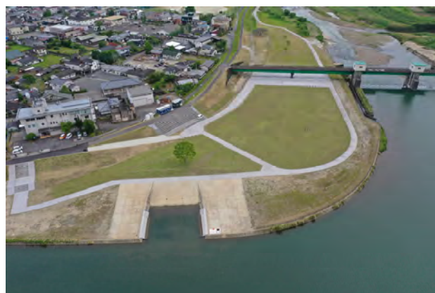
写真-6 工事着後写真
