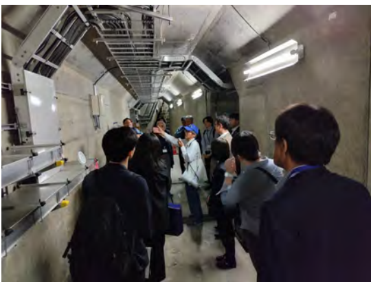
普段入れないダム内部にて漏水量や変位管理の説明
