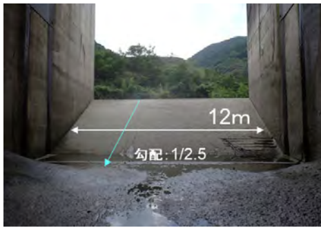
写真-3 仮排水路トンネル呑口部
