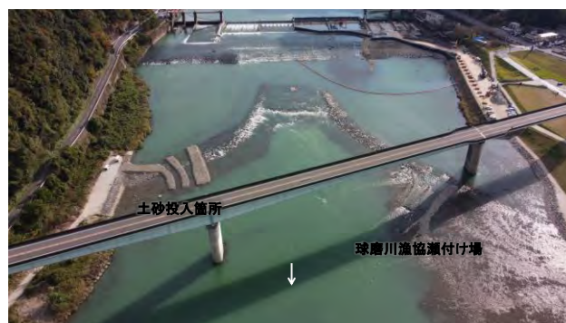
図-2 八の字堰における土砂投入箇所
