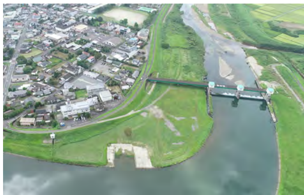
写真-5 工事着手前写真
