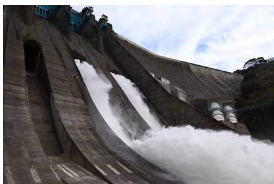
図-6 オープニングセレモニー（上）と点検放流（下）の様子。
