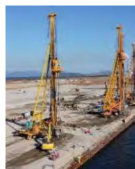
写真-2 施工状況
