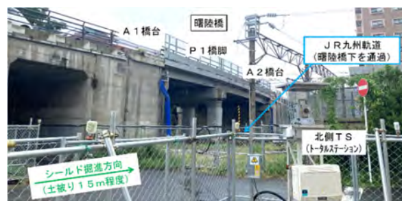
図-17 曙陸橋およびJR九州軌道一北側の概況
