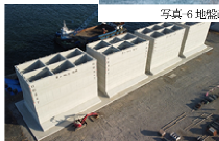
写真-7 本体工（ケーソン製作）
