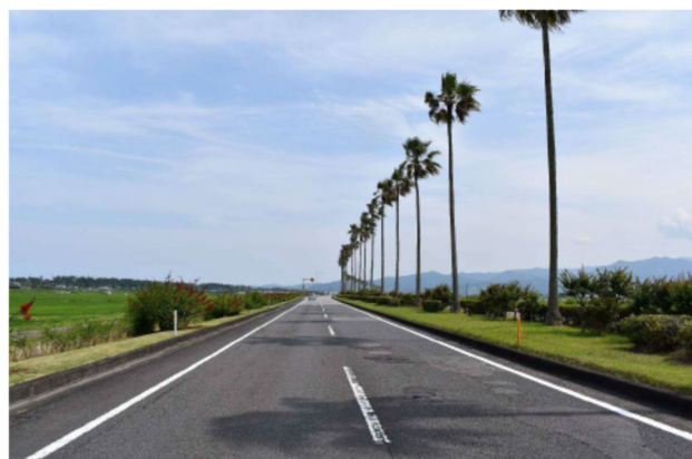
図-5 施工前の舗装状況
