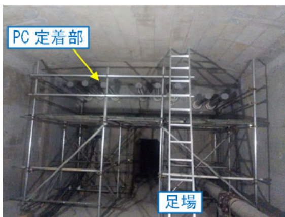
(図-16) 外ケーブル定着部点検用足場の状況
