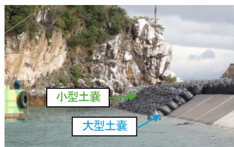
図-11 端部の施工状況
