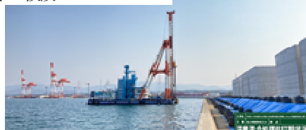
写真-6 地盤改良工
