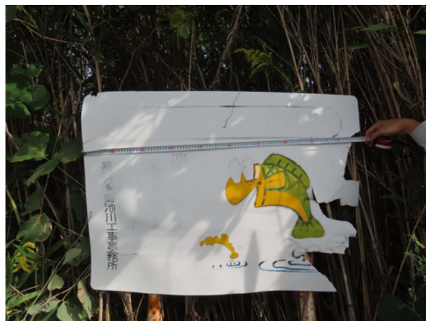
写真-1 一部破損している管内看板
