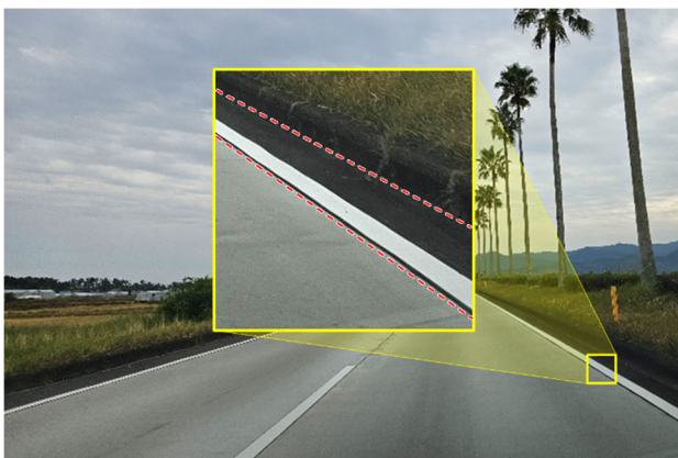
図-13 施工後の区画線の状況
