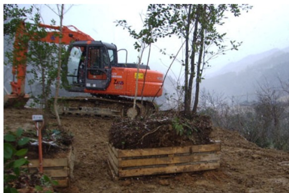
写真-2 生態移植工法の施工状況
