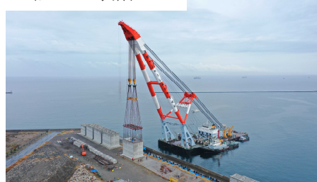
写真-8 本体工（ケーソン据付の様子）
