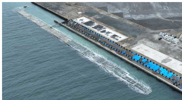
写真-9 ケーソン天端が水没する様子
