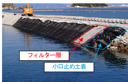
図-10 小口止めの施工状況
