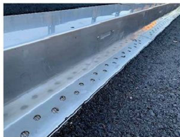
写真-6鋼製排水溝
