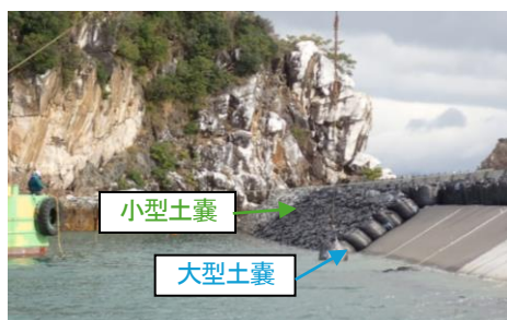
図-11 端部の施工状況
