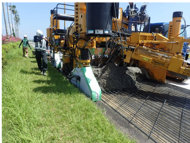
図-3 スリップフォーム工法による施工状況
