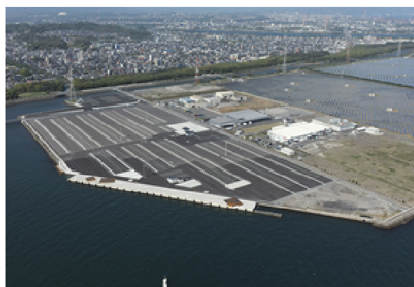
写真-13 整備後の大在西地区
