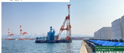
写真-6 地盤改良工
