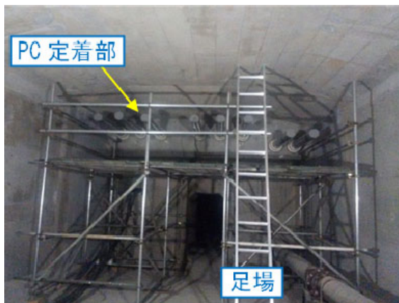
(図-16) 外ケーブル定着部点検用足場の状況
