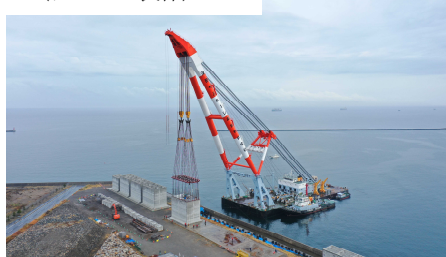
写真-8 本体工 (ケーソン据付の様子)
