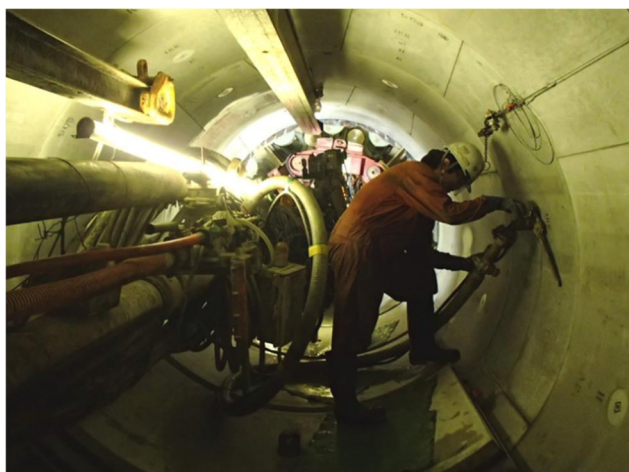
写真-1 導水路トンネル（工事中）
