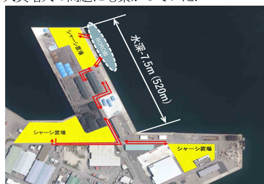
写真-1 大分港(大在地区)航空写真
