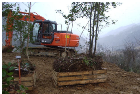
写真-2 生態移植工法の施工状況
