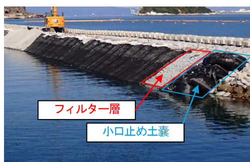
図-10 小口止めの施工状況
