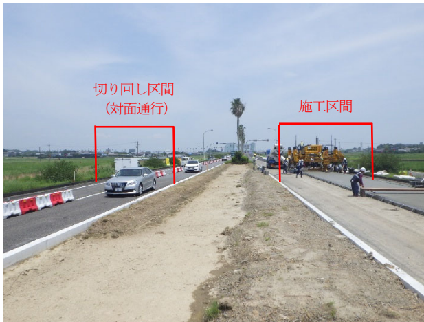
図-12 施工区間の規制状況
