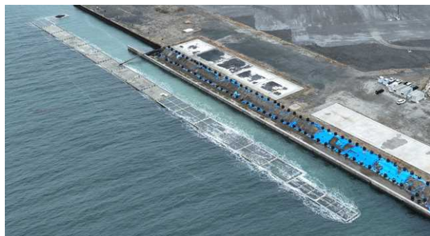
写真-9 ケーソン天端が水没する様子
