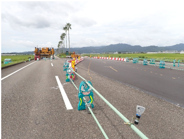
図-8 シフト区間状況（中央分離帯を一時撤去）
