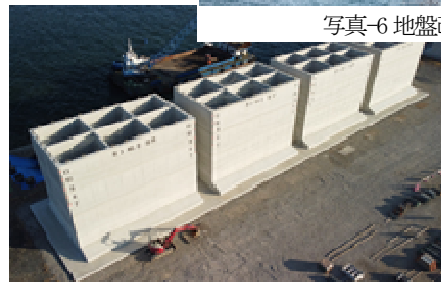
写真-7 本体工 (ケーソン製作)
