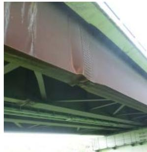
橋の主桁に生じた変形
