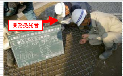
(河川護岸用かごマットの材料確認)
