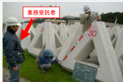
(根固めブロックの材料確認)
