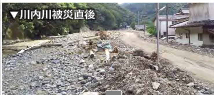
▼土砂撤去状況
