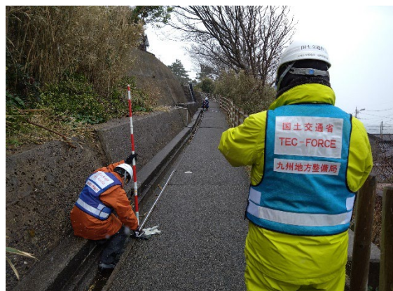
▲現地調査状況 （被災状況調査班（道路））
