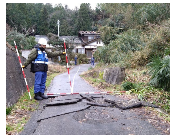
▲現地調査状況 （被災状況調査班（道路））
