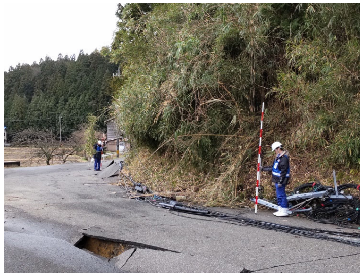
▲現地調査状況（被災状況調査班（道路））
