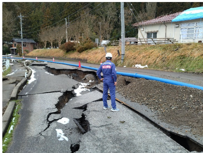
▲現地調査状況 （高度技術指導班（水道））
