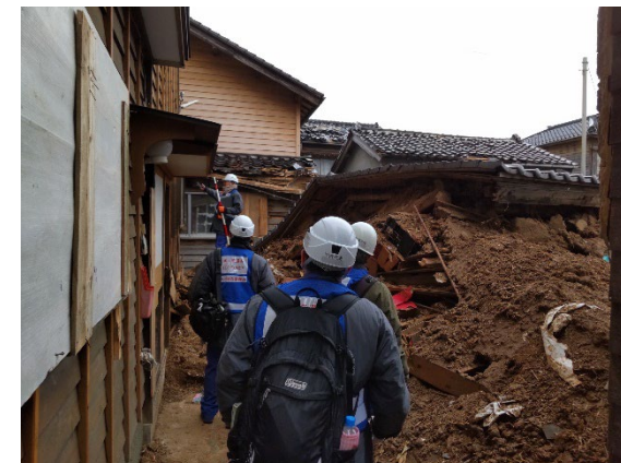
▲現地調査状況 （被災状況調査班（道路））
