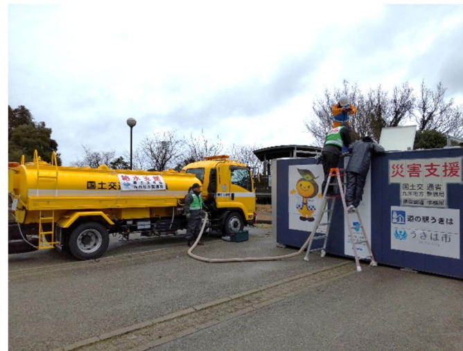
▲防災用コンテナ型トイレの設置・給水状況
