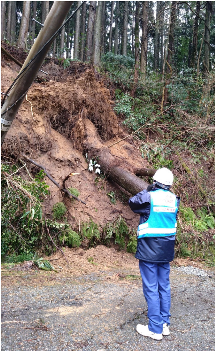
▲道路の被災状況調査状況 （被災状況調査班（道路））
