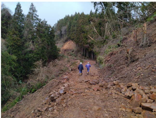
▲被災状況調査状況 （高度技術指導班（水道））
