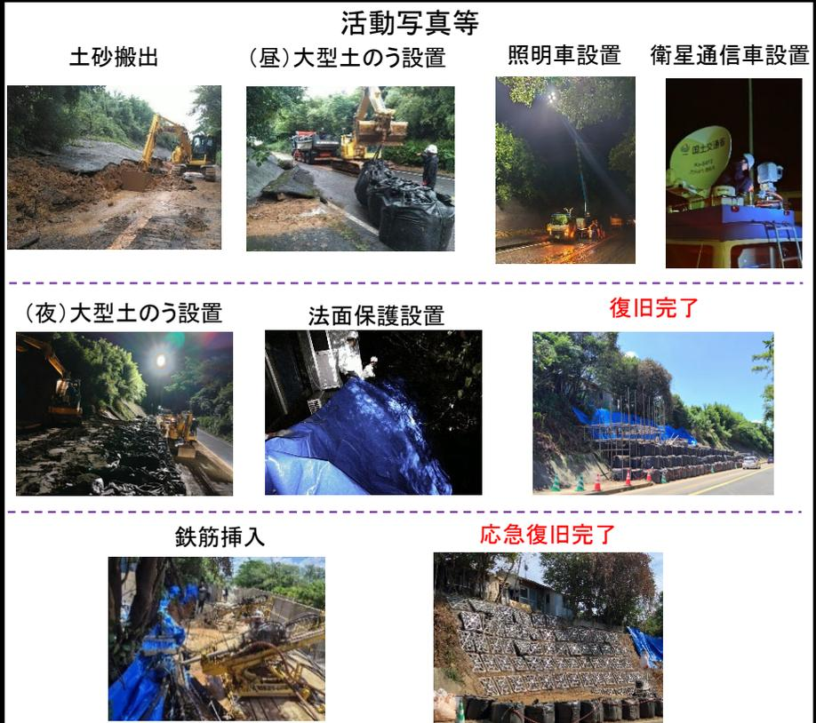
○(被害状況):令和6年7月14日11時30分頃、降雨の影響で斜面崩壊が発生した。延長約40m、高さ約10m、幅約12mの被害規模で、出水市境町の国道3号へ土砂等が流入した。
