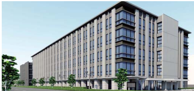
鹿児島第3地方合同庁舎(イメージ):鹿児島県鹿児島市
