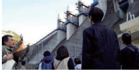
ダムの圧倒的なスケールを体感 (耶馬溪ダム)
