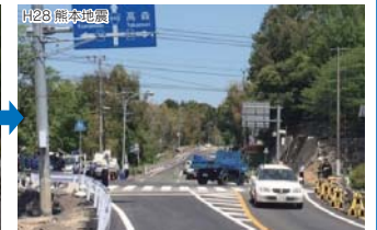
道路啓開支援により 8 日間で復旧 (H28.4.23 国道 443 号 [県管理])
