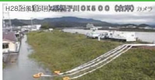
ポンプ車による排水 (H28.9.20 五ヶ瀬川水系祝子川)
