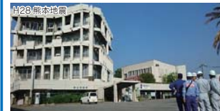
市役所庁舎の被災調査を実施 (H28.4.19 熊本県宇土市)
