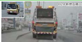
路面清掃車による降灰除去 (H24.1.27 国道 10 号)
