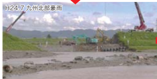
緊急復旧工を実施 (H24.7.15 矢部川)
