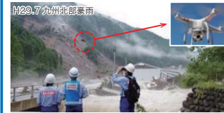
被災箇所の調査状況 (H29.7.7 日田市小野)
