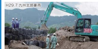
権限代行制度により緊急工を実施 (H29.7.19 赤谷川 [県管理])
