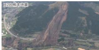
阿蘇大橋崩落箇所の調査 (H28.4.16 南阿蘇村)
