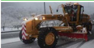
除雪グレーダによる除雪 (H30.1.22 国道 57 号)
