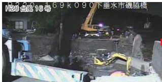
24 時間体制で緊急復旧工を実施 (H28.9.21 国道 220 号)
