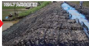
3 日間で応急復旧完了 (H24.7.17 矢部川)
