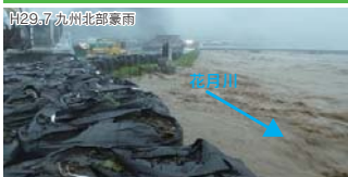
大型土のう積み (H29.7.5 筑後川水系花月川)
