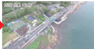
仮橋により 7 日間で応急復旧 (H28.9.27 国道 220 号)
