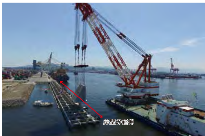
コンテナ岸壁の延伸事業(博多港アイランドシティ地区)
