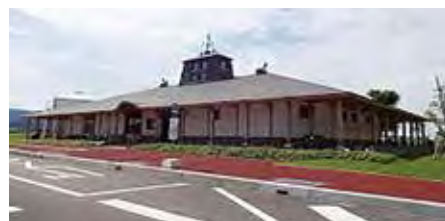
みなとオアシス薩摩川内（鹿児島県 薩摩川内市） 代表施設：川内港ターミナル
