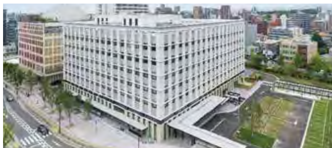
まちづくりと調和した施設づくり（令和元年7月完成）
