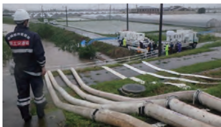
浸水地域の排水作業
