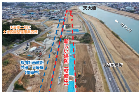
流下断面拡大のための堤防(引堤)を整備 (川内川河川改修事業)
