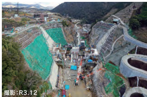
治水ダムの建設 (立野ダム建設事業)
