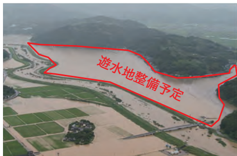
激甚な水害が発生した地域での遊水地整備 (六角川水系における河川激甚災害対策特別緊急事業)
