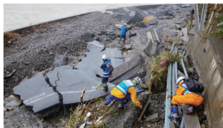
道路被害の調査
