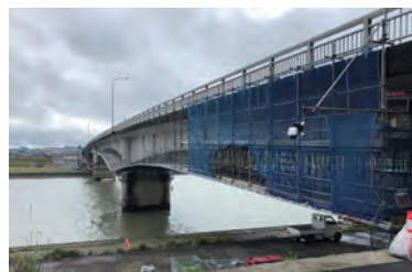
橋梁修繕代行(天大橋:薩摩川内市市道)
