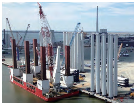
海外港湾の洋上風力発電設備の取扱事例 (エスピアウ港(デンマーク))
