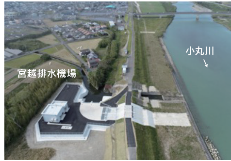
完成した排水機場 (宮越地区総合内水対策事業)
