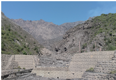
荒廃地域に設置された砂防堰堤 (桜島直轄砂防事業)
