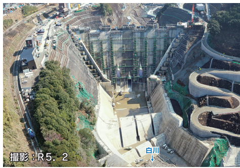
治水ダムの建設 (立野ダム建設事業)
