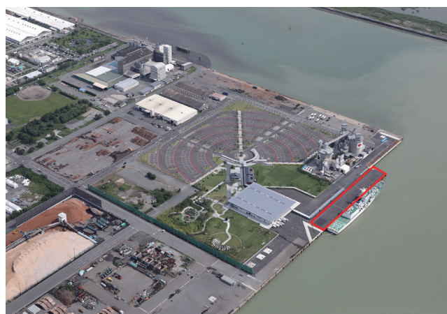
耐震強化岸壁(緊急物資対応)完成(八代港)
