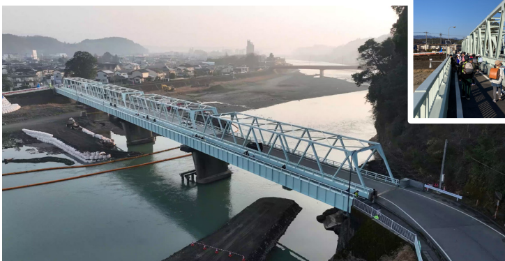
西瀬橋架替完了（R5. 2時点）
