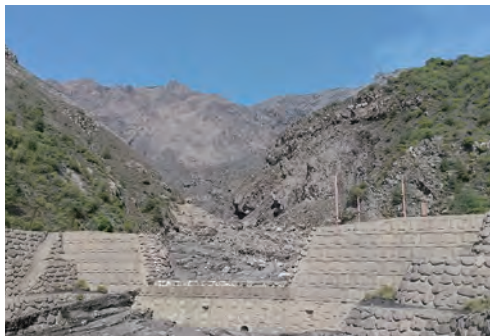
荒廃地域に設置された砂防堰堤 (桜島直轄砂防事業)
