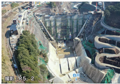
治水ダムの建設 (立野ダム建設事業)
