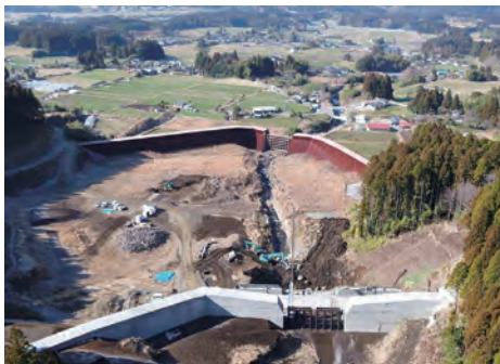
砂防堰堤の建設 (阿蘇山直轄砂防事業)
