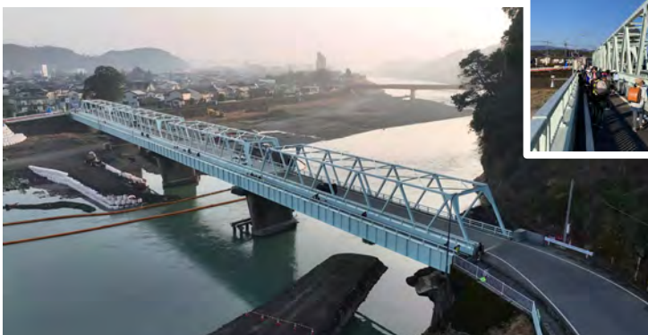
西瀬橋架替完了（R5.2時点）
