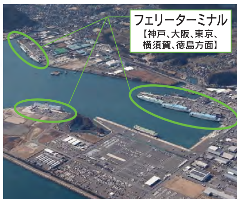
フェリーターミナルの整備 (北九州市港新門司地区)
